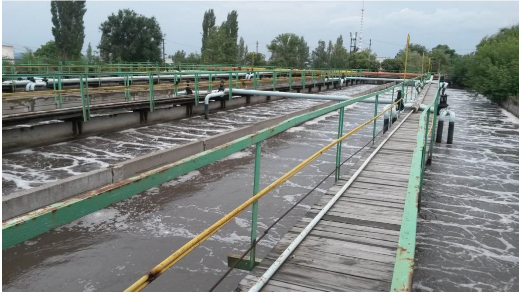
Рисунок 22 - Аэротенки
