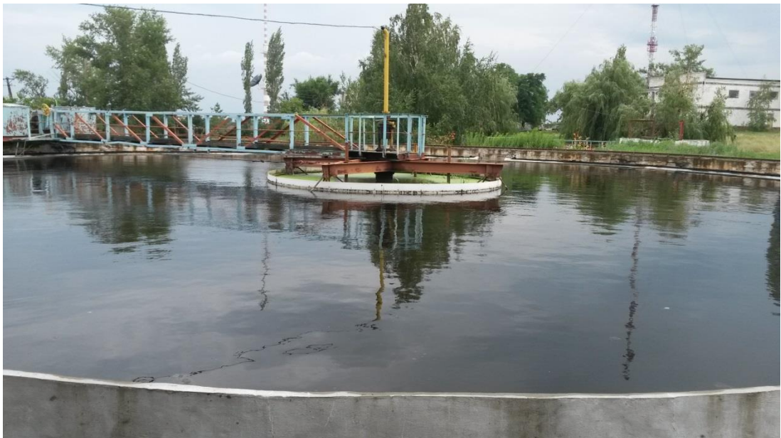
Рисунок 23 - Вторичный отстойник
